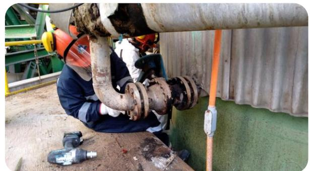
**Apertura y cierre equipos periféricos L1 (Intercambiadores de calor, Condensadores, enfriadores etc.) (mayo 2023)**
